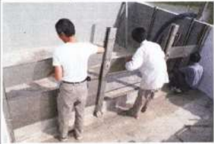
圖 1 防水閘門安裝
